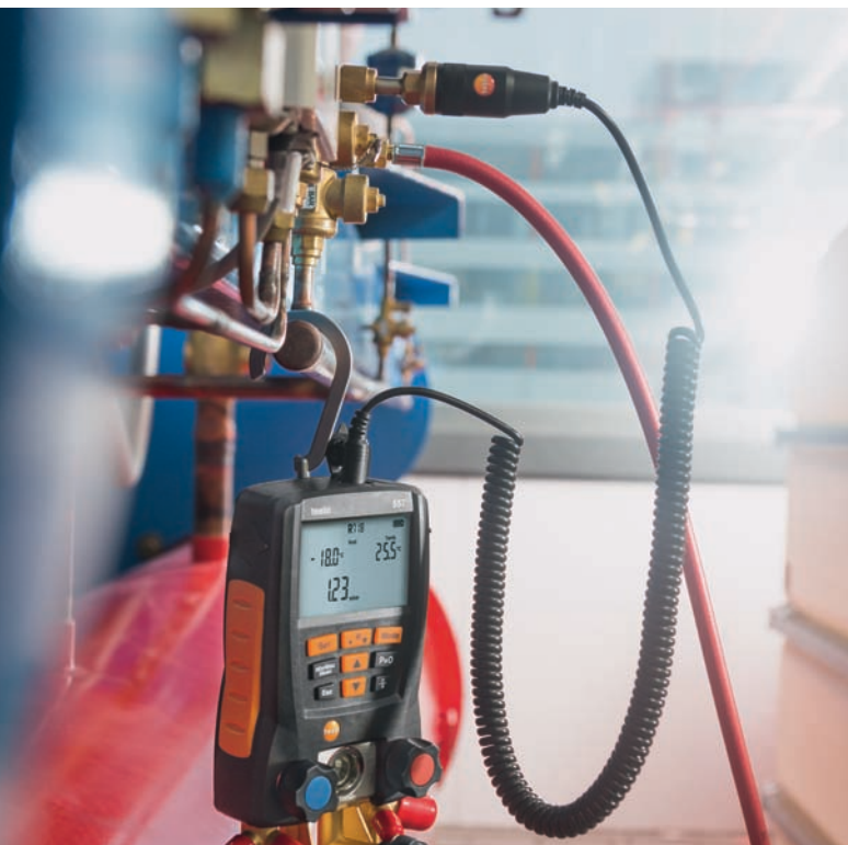
Высокоточное измерение вакуума: testo 557 с внешним зондом
