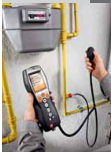
Проверка герметичности газовой трубы
