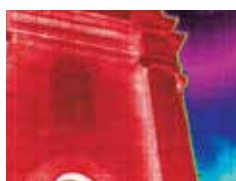
Тепловидение выявляет скрытые конструкции окон, невидимые человеческим глазом
